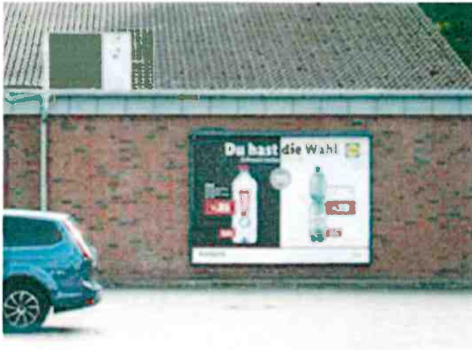
Beispiel 6: Positive Wirkung durch Gliederung einer langen ausdruckslosen Fassade durch Werbung in angemessener Größe zum Betrieb (Bild oben links).
